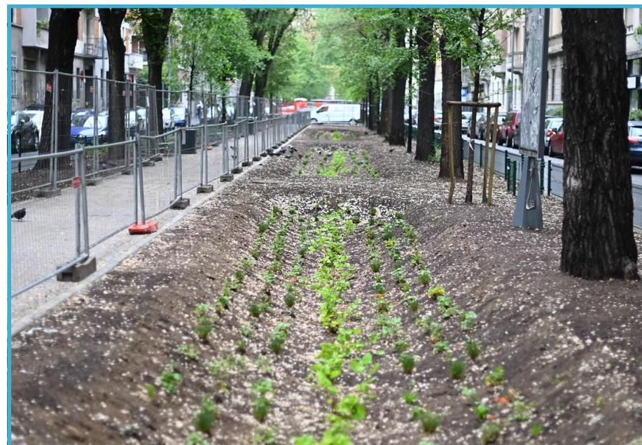
Sistemi di Drenaggio Urbano Sostenibile per migliorare la sicurezza idraulica e mitigare le temperature
